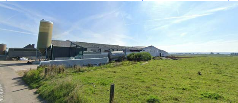
overzichtsbeeld vanuit het noordwesten (Groenstraat) (bron: google.be/maps)
