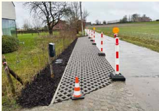
Uitvoegstrook in grasbetontegels met waterdoorlatende ondergrond in de Pareelstraat.
